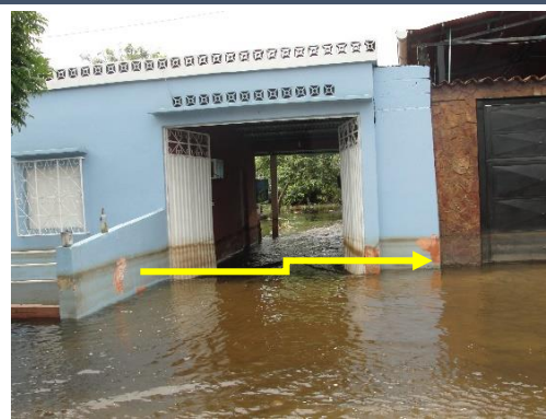
Foto 02: Marca de nivel de agua en la vivienda
